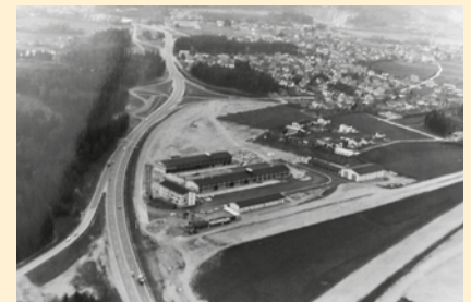
Die Autobahnmeisterei Villach-Zauchen kurz vor der Fertigstellung (Blickrichtung Westen).
