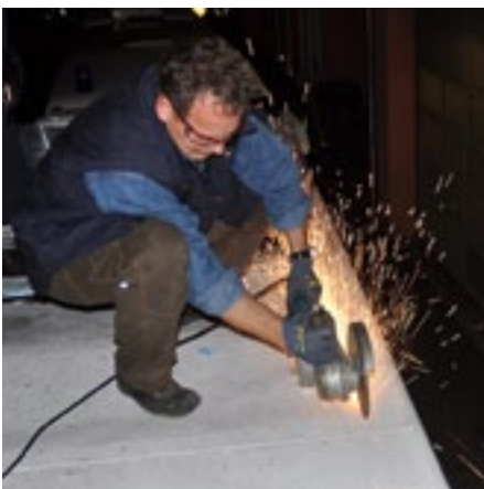
Nachdem mit einer Flex das Dach geöffnet wurde ...
