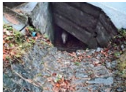
... um in weiterer Folge über die glatten Steine in einen Wasserdurchlaufschacht zu stürzen.
