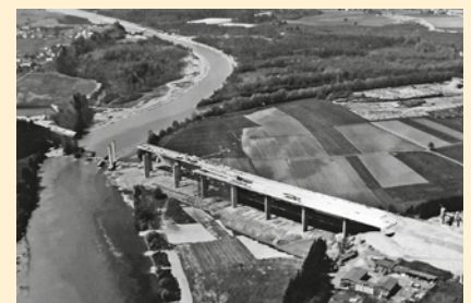
Der Bau der Südbahn begann in den 1960ern .
